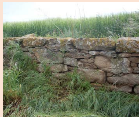
Imatge 5. Marge de pedra seca a conservar.
