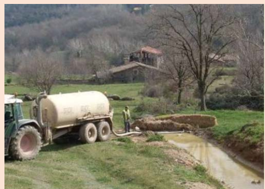
Imatge 4. Barrera de sediments (bales de palla).
