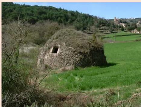
Imatge 1. Caseta de pedra seca a conservar.
