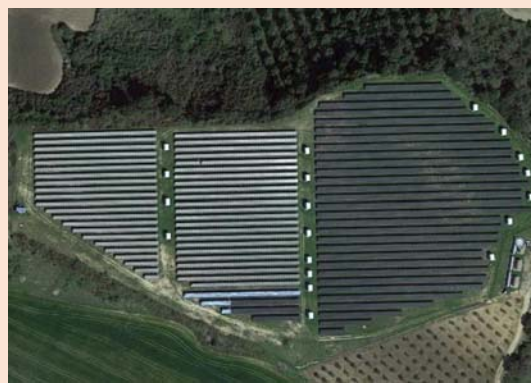
Imatge 4. Barreja de dos tipus de panells en una PSF a Ronda, Màlaga (a evitar). S'observa com la tonalitat negra dels panells s'integra millor.
