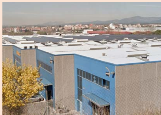
Imatge 2. Plaques situades en cobertes industrials (Parets del Vallès).
